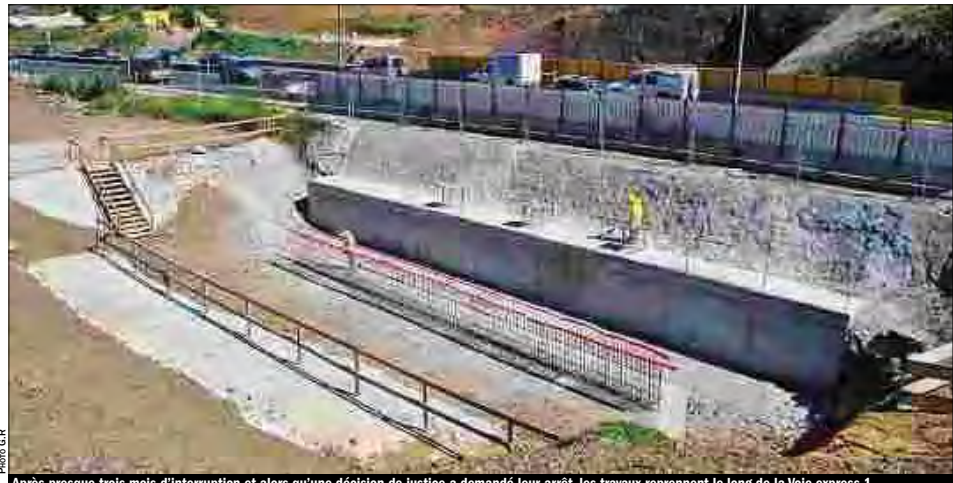
Après presque trois mois d'interruption et alors qu'une décision de justice a demandé leur arrêt, les travaux reprennent le long de la Voie express 1.
